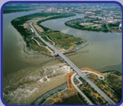
Baraj Sg. Sarawak
